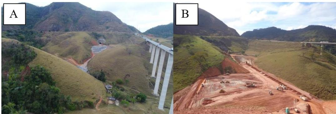
**Figura 2** - Grota seca a ser cruzada pelo traçado (A) e execução do corpo do aterro (B).
